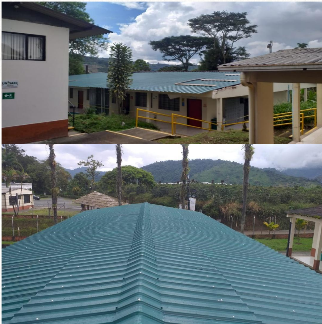
Figura 49. Nueva cubierta de techos
