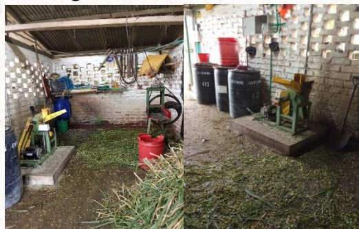
Figura 53. Adecuación eléctrica pica pasto
