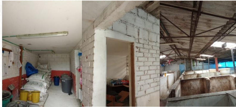
Figura 53. Adecuación área porcina
