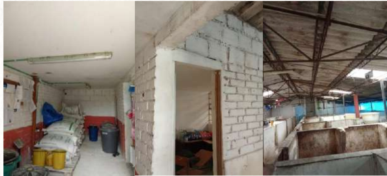
Figura 53. Adecuación área porcina
