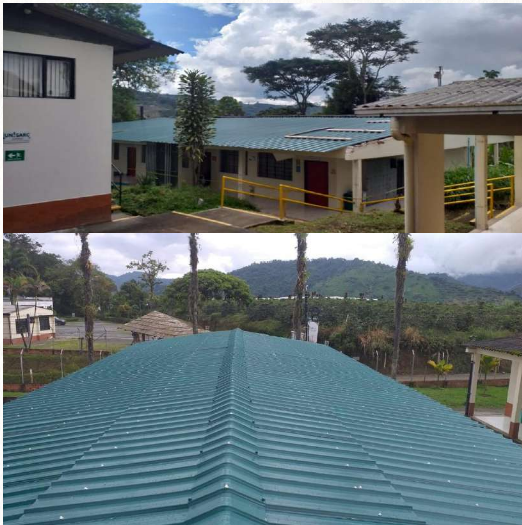
Figura 49. Nueva cubierta de techos
