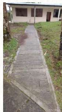
Figura 51. Andén acceso a salas de sistemas
