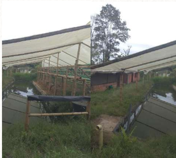
Figura 58. Adecuaciones estanque de peces
