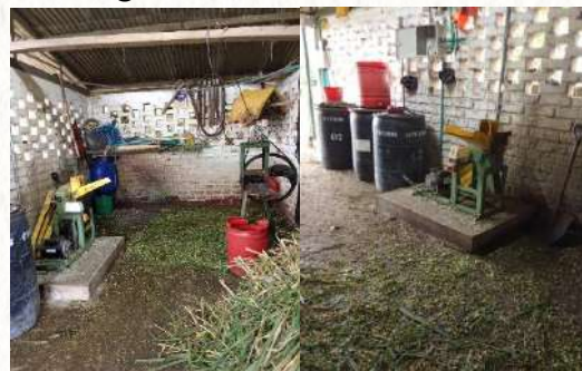
Figura 53. Adecuación eléctrica pica pasto
